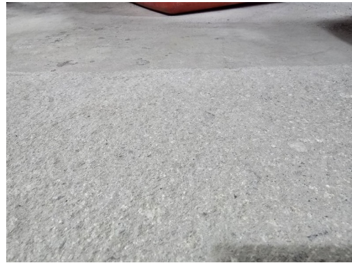
④ 처리 후 접사 — 모르타르층 제거, 골재 노출
